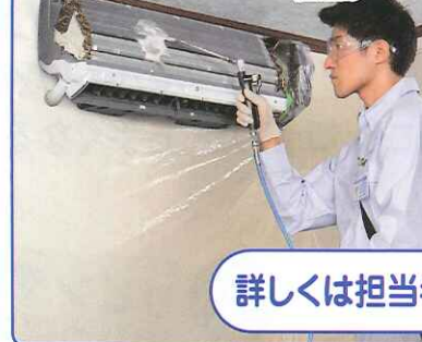
エアコンクリーニング 抗菌・防カビ仕上げ
